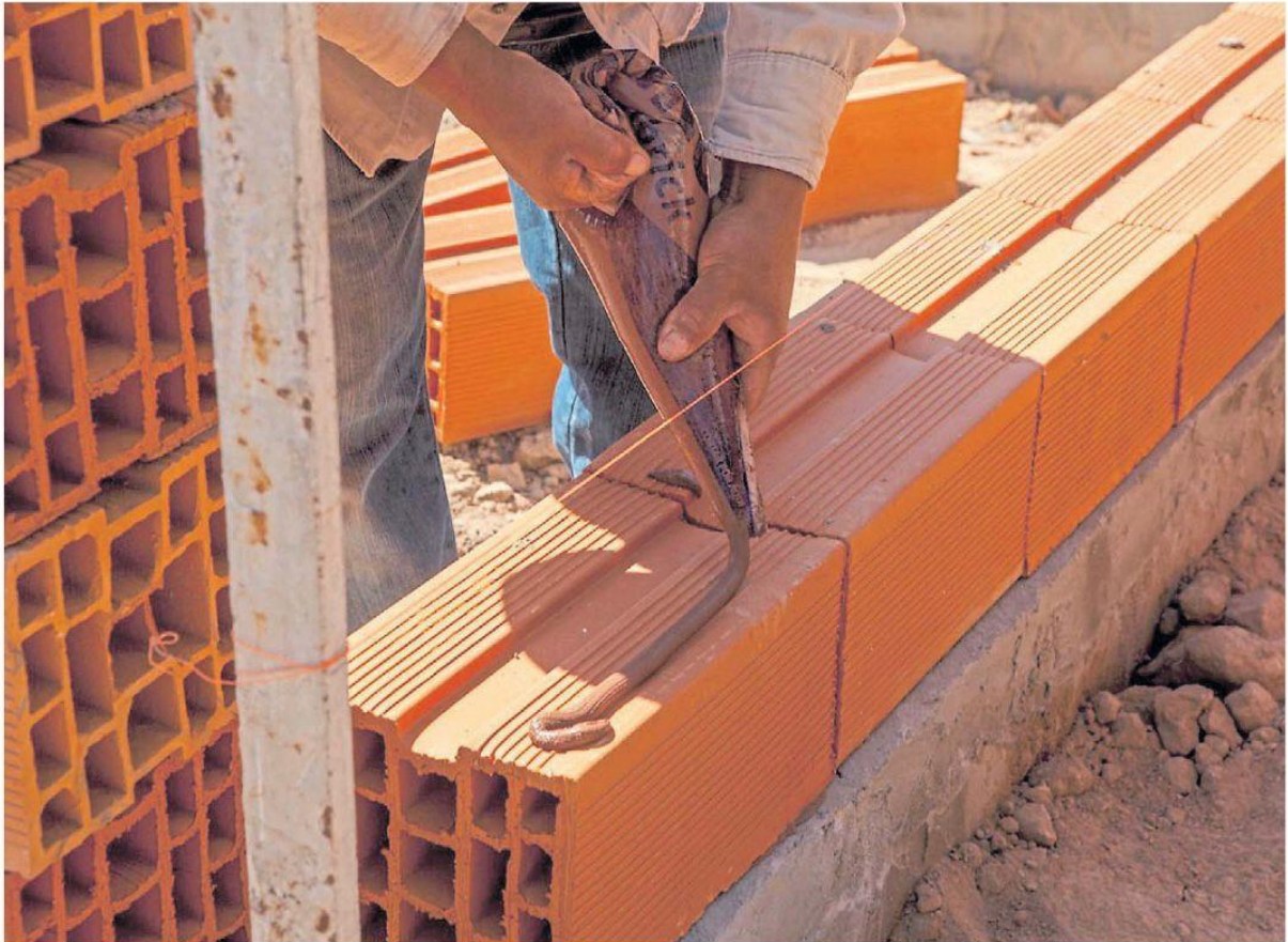
BLOQUE DM 20. Los ladrillos termoaislantes se pueden colocar con morteros poliméricos premezclados que se aplican con manga.
